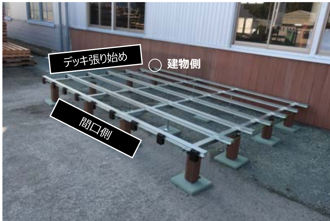
建物側（根太材木口側）
