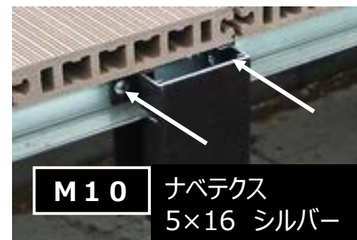
デッキ木口側（根太材木端側）
