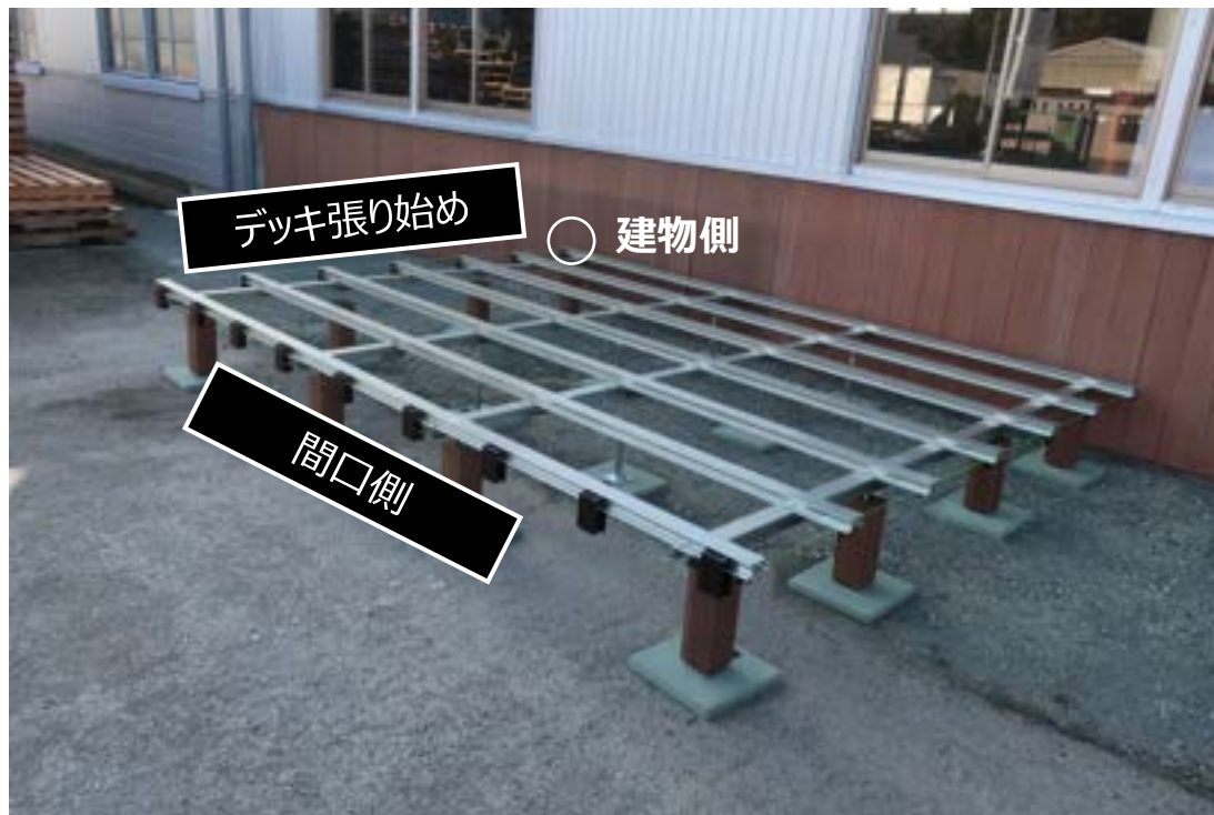
建物側（根太材木口側）
